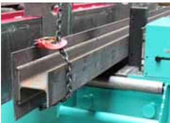
119 Geschweisste Träger richten Welded beam straightening
