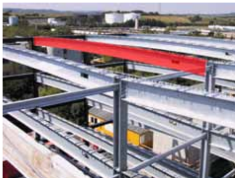
271 Träger vorspannen im Stahlbau Beam cambering
